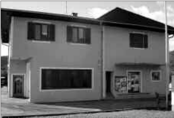
Der neue Zubau zum Feuerwehrhaus in Friesach-Wörth.
