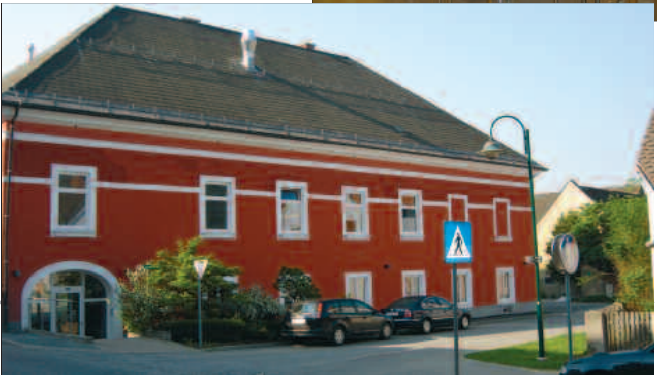
Nordansicht des neuen Gemeindegemeinschaftszentrums.
