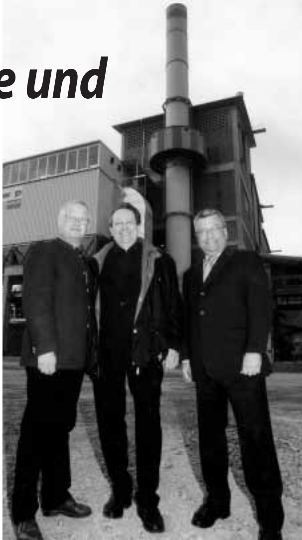
Bmstr. Ing. Bachinger, Bürgermeister Rois und DI Glinz vor der neuen Filteranlage bei W&P in Peggau.
