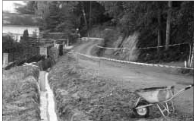
Verbreiterung der Friesachstraße Richtung Norden.
